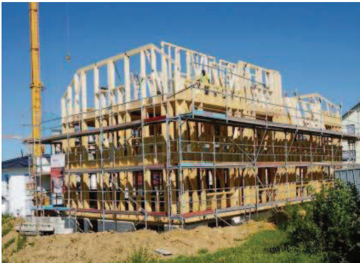
Ein Holzfachwerkhaus der besonderen Art ist das neue Mehrfamilienhaus auf dem Horber Hohenberg. Bei schönstem Wetter wurde Richtfest gefeiert (Seite links). Bilder: DIE WERKSTATT
